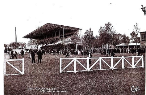
Nouvelles tribunes en béton armé et charpente métallique édifiées à l'emplacement des anciennes tribunes en bois, carte postale (copie numérique), vers 1930, AMC.
