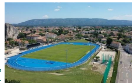
Nouvelle piste en revêtement synthétique imperméable (granulats d'EPDM : caoutchouc coloré), 2020, photogr. Service des Sports.
